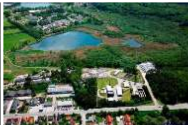
Skanderborg Rensningsanlæg ved Svanesø
